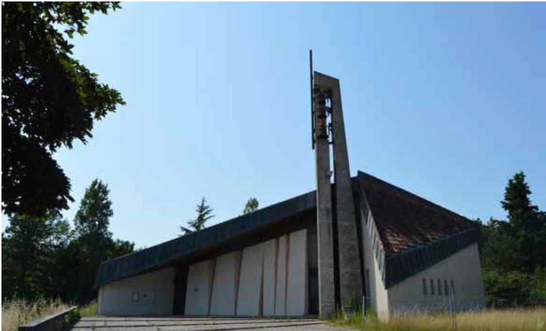
Villeneuve-sur-Lot - Église de Courbiac © Communauté d'Agglomération du Grand Villeneuvois
