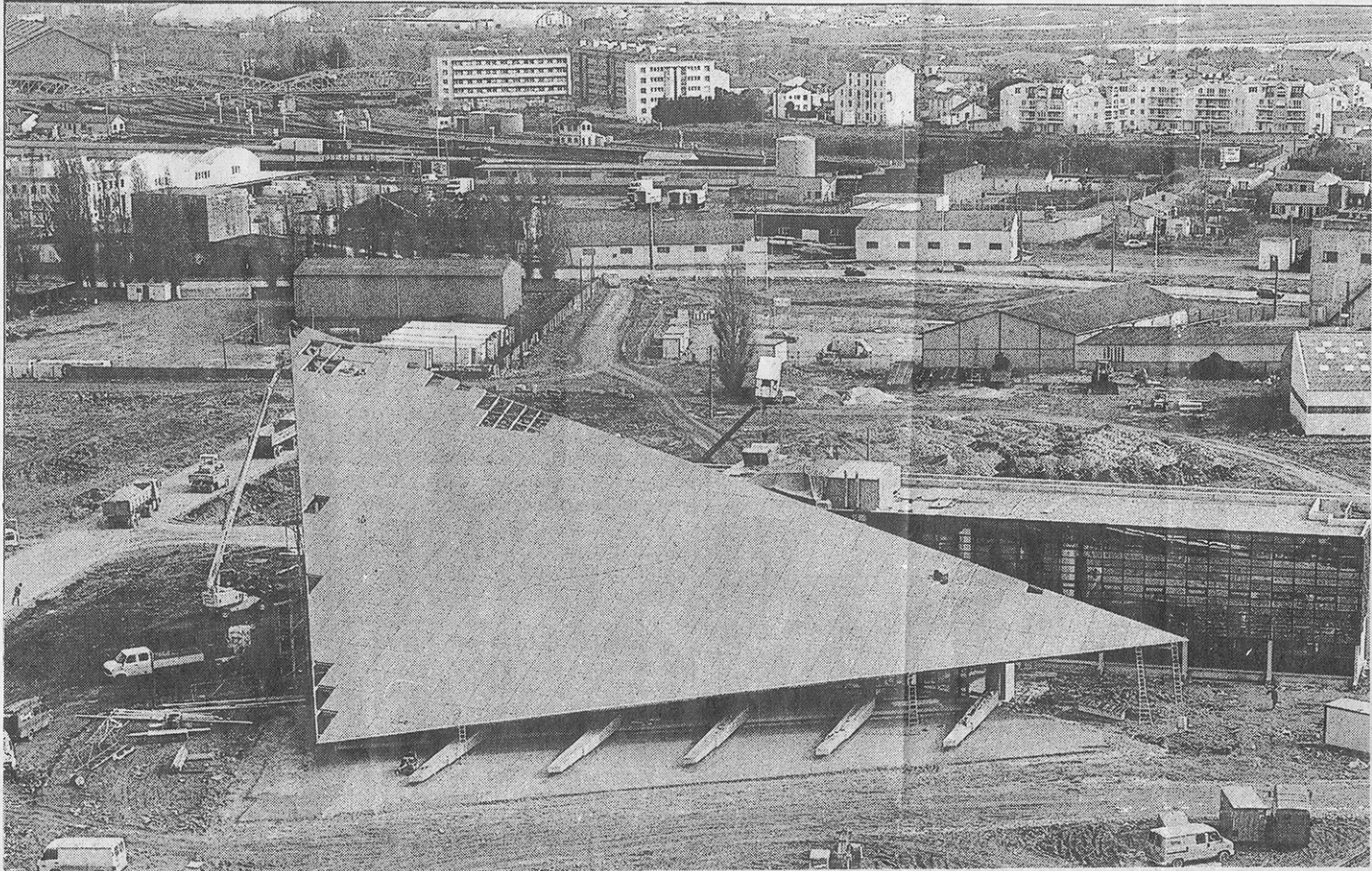
L'aile du Technoforum est sortie de terre. Dans deux mois, les aménagements seront terminés (Photo Tadeusz Kluba.)
